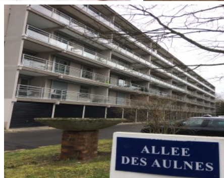
Appartements des Aulnes
